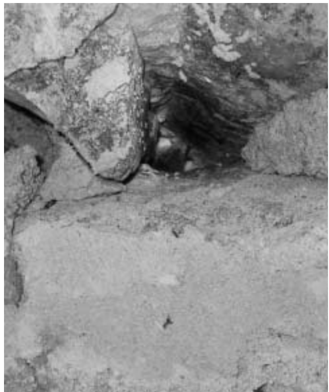
Coucou qui est encore là ? Un Murin de Natterer à Pers (15) après rénovation (Joël Bec©)
