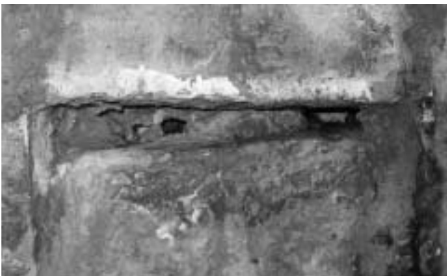
Cavité ratée : reste de papier et pénétration du mortier dans le gîte (Joël Bec©)
