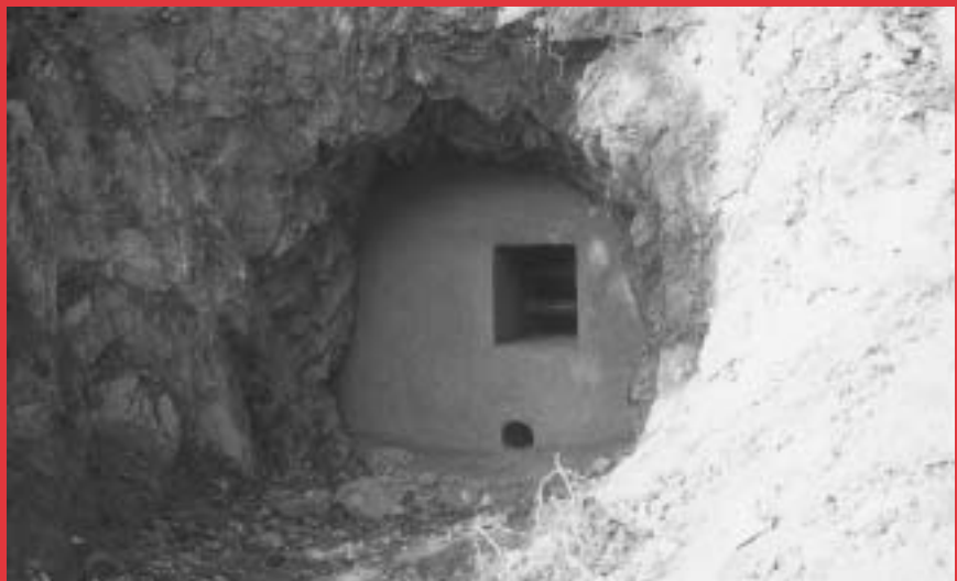
Galerie sécurisée à Massiac (15) (CEPA©)
