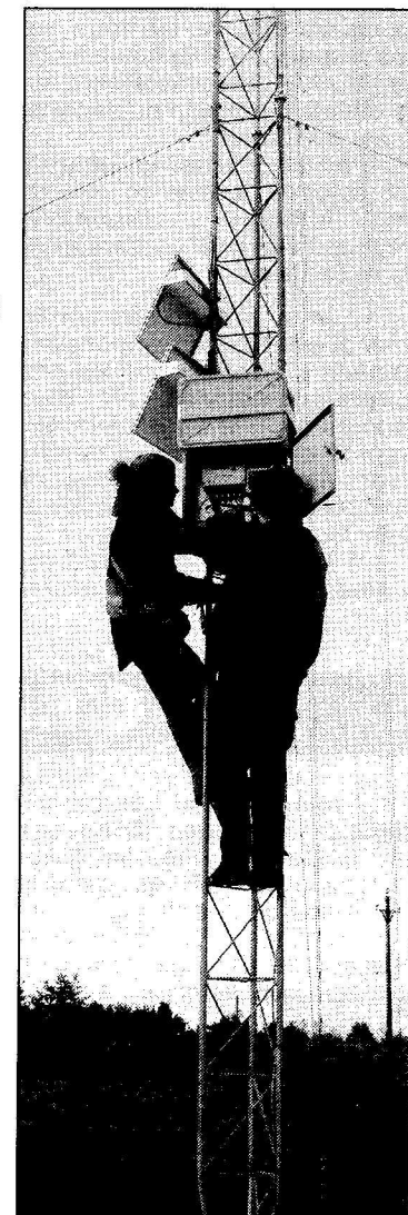
Derniers réglages avant de céder la clef du coffre électrique à Michel
