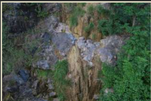
Écoulement calcaire avec concrétion © H. PICQ
